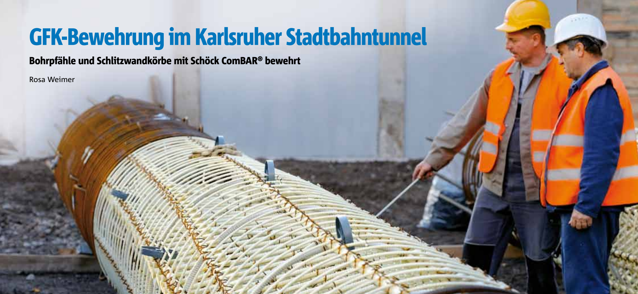
Beim Bau des Karlsruher Stadtbahntunnels sind die Bohrpfähle und Schlitzwandkörbe mit Schöck ComBAR® bewehrt.
